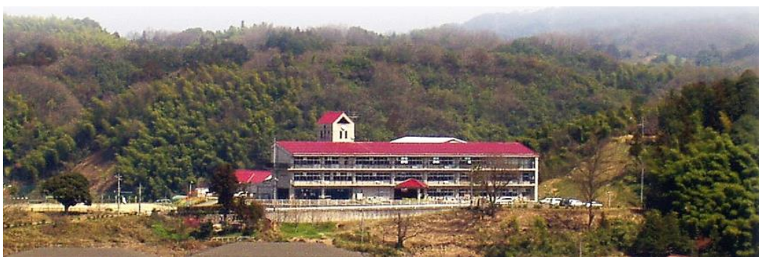
図1 寺領小学校校舎。左側に寺領幼稚園の赤い屋根が、右側に赤土の丘の斜面が見える。
